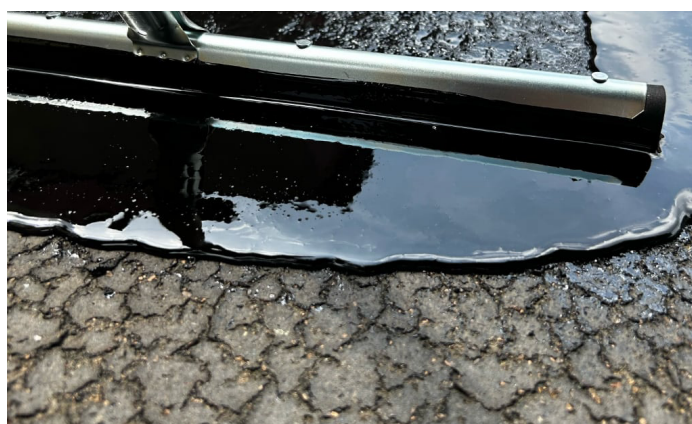
AANBRENGEN MET RAKEL VOOR EGALE VERDELING
