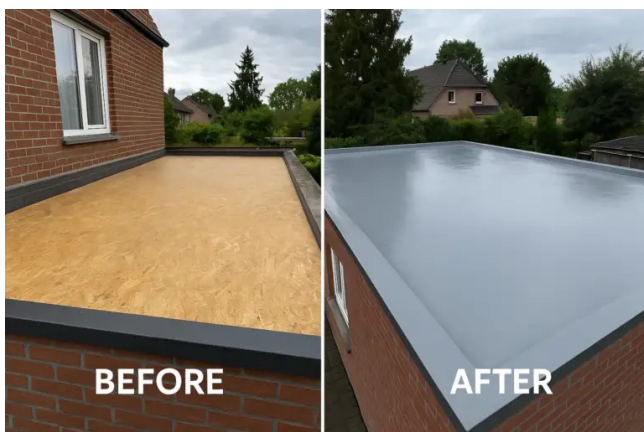
Voor/Na — Hybrid Waterproofing
