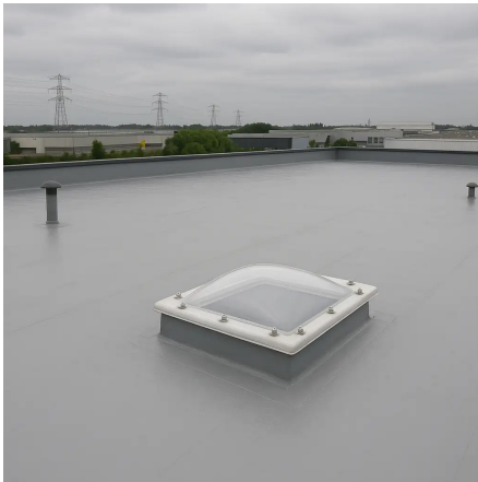
Industrieel dak — volledige afdichting
