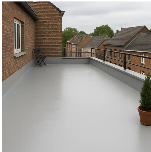
Residentieel plat dak — na applicatie van de Hybrid Waterproofing
