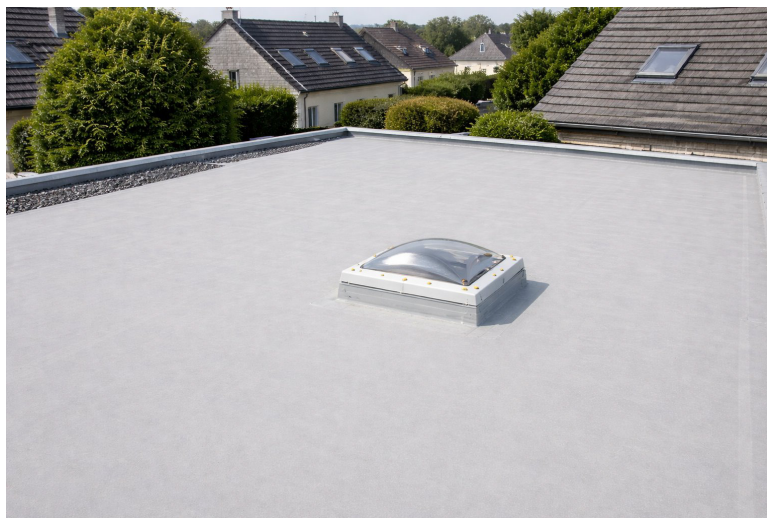
Plat dak na applicatie — homogeen en waterdicht resultaat
