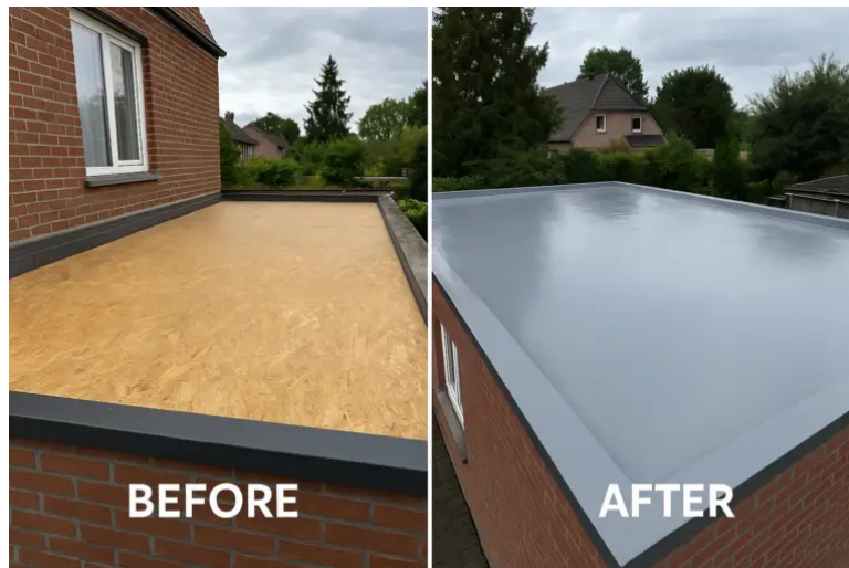
Voor / Na — Applicatie van de Hybrid Waterproofing op een dak
