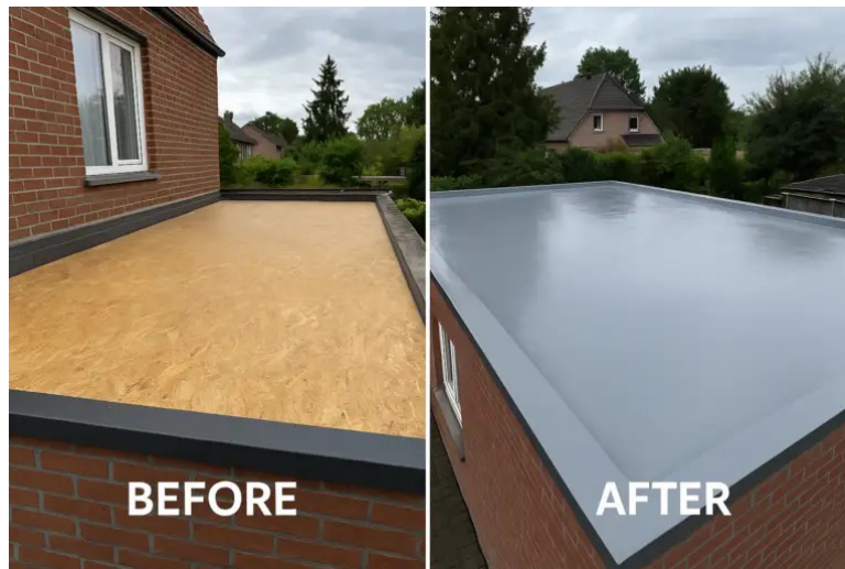
Avant / Après — Application du Hybrid Waterproofing sur toiture
