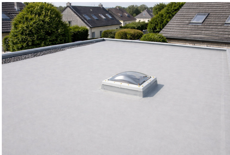
Toiture plate après application — résultat homogène et étanche
