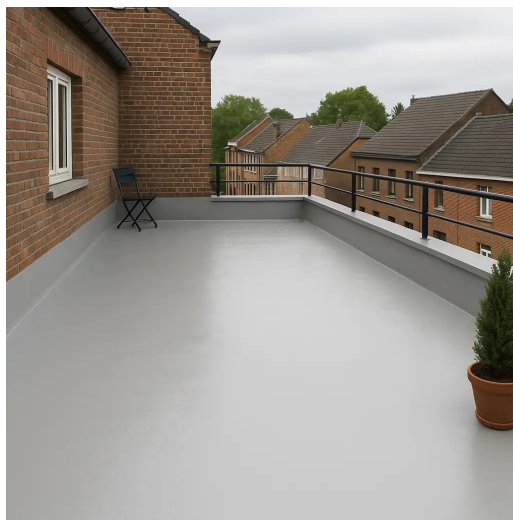
Toiture plate résidentielle — après application du Hybrid Waterproofing
