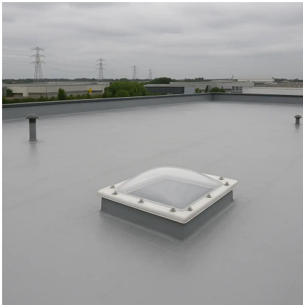
Toiture industrielle — étanchéité complète
